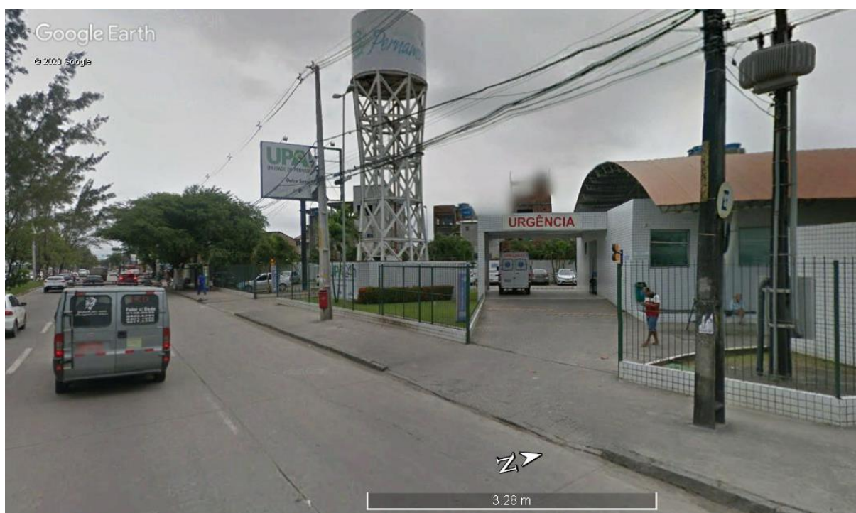
Figura 20 – Unidade de Pronto Atendimento (UPA) na AV. Eng. Abdias de Carvalho (Fonte: Google Earth StreetView, 2019)
