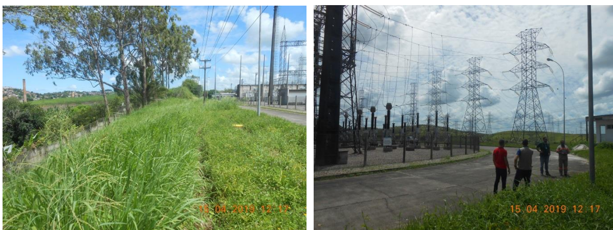
Figura 3 – Fotos da SE Recife II. Análise sobre o espaço de entrada e saída da nova LT Recife II – Bongi, em que foram levantadas a necessidade de obras civis e interferências fundiárias (Fonte: EPE, 2019)
