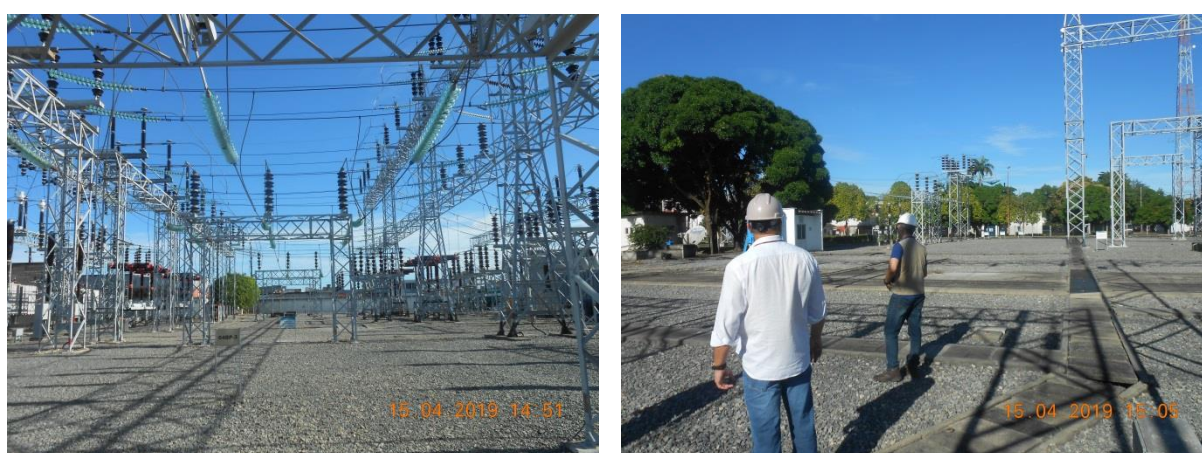
Figura 5 – Fotos da SE Bongi. Análise sobre o espaço de alocação de novos equipamentos elétricos, além das eventuais interferências da nova LT Recife II – Bongi nas infraestruturas existentes da subestação (Fonte: EPE, 2019)
